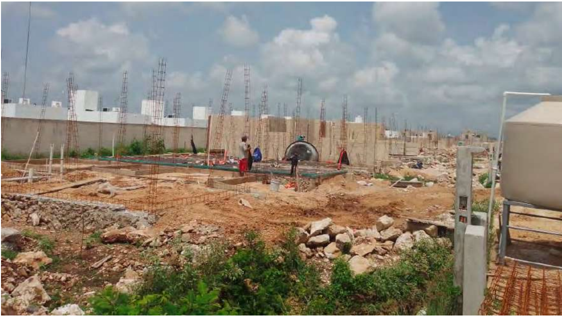
Construcción de vivienda en serie. Fotografía: Ing. Edson Rodríguez.
